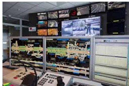
setec est régulièrement en mission au service des exploitants, comme ici dans le PC des tunnels du BPNL (Lyon).
