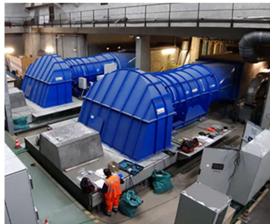
setec tpi assure la maîtrise d'œuvre du remplacement des 24 ventilateurs du tunnel transfrontalier du Fréjus (13 km).
