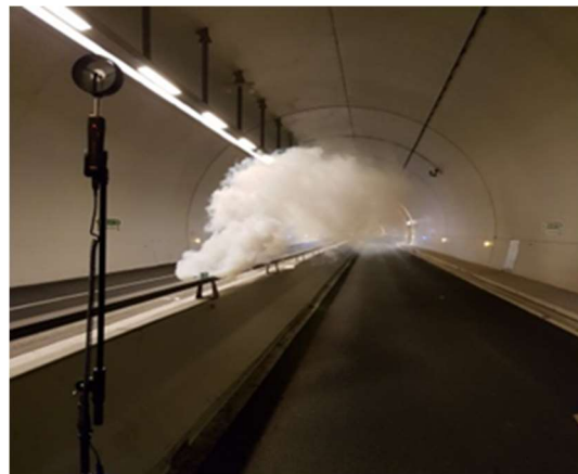
Lors des IDI / IDP, setec vérifie l'atteinte des performances de la ventilation, comme ici dans le tube « modes doux » du tunnel de la Croix-Rousse à Lyon (1,8 km).
